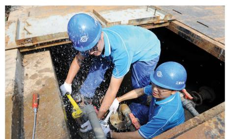
近期，机电维修中心顺利完成肖山水厂应急投加管道安装。为不影响正常供水，铺设管道时，施工人员带水安装，在灌水的阀门井里施工作业，顺利完工全长约2000多米的管道铺设，为供水安全保驾护航。
