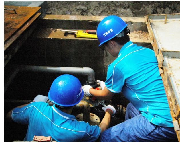
公司机电维修中心加强供水设备的巡检维护，近日更换了肖山水厂一、二期加矾管道，对三期加矾管道进行压力水冲洗，消除管中积垢，排除了加矾管路堵塞的隐患，保障了出厂水水质的达标。
